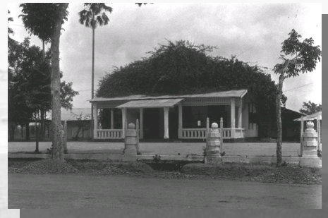
Het sociëteitsgebouw te Djember
